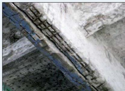
Figura 3: As vigas com as armaduras enferrujadas
