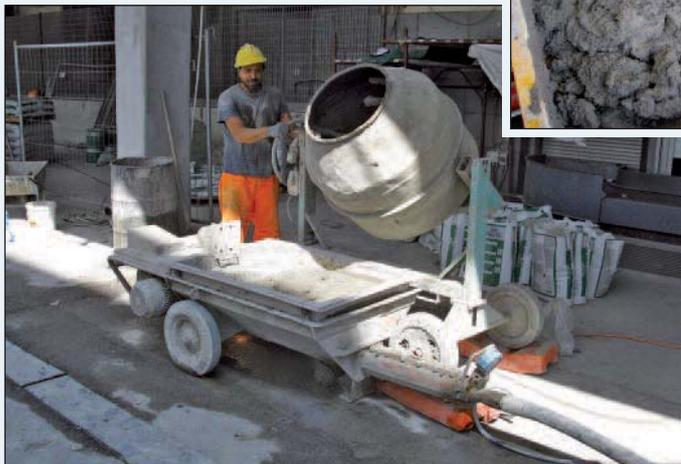
Figura 4: Descarga da betoneira na tremonha da máquina
