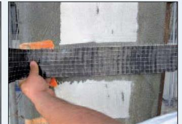
Figura 7, 8 e 9: As fases de revestimento das estruturas deterioradas com bandagens em material FRP
