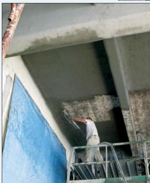
Figura 6: O revestimento tem espessuras de até 4-5 cm.
