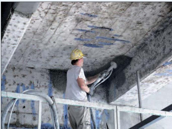
Figura 16: A projeção da argamassa cimentícia tixotrópica de retirada controlada
