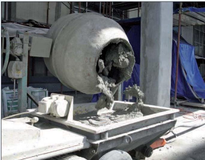
Figura 15: A descarga do Emaco Formula Tixo na tramonha.
