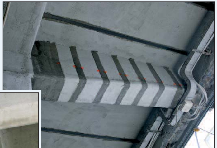
Figura 10 - Una trave trattata con FRP e relative resine
