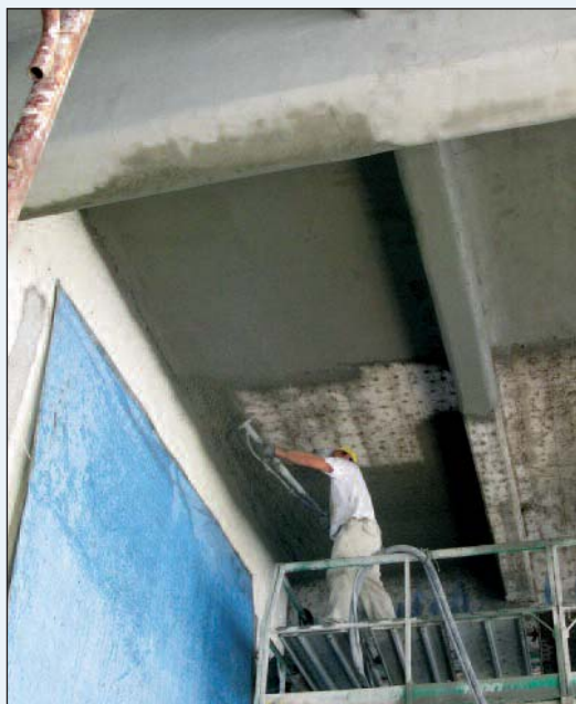
Figura 6 - La rasatura ha spessori fino a 4-5 cm
