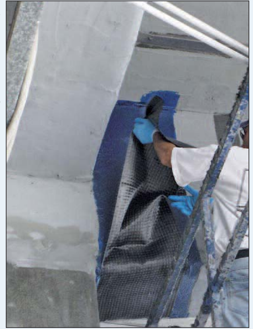
Figure 7, 8 e 9 - Le fasi di ricopertura delle strutture ammalorate mediante fasciature in materiale FRP
