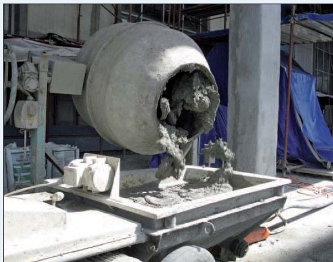
Figura 15 - Lo scarico dell'Emaco formula Tixo nella tramoggia
