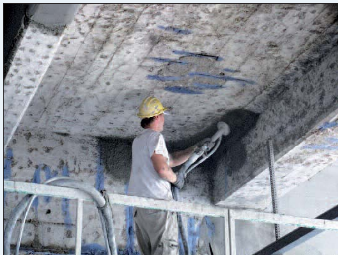
Figura 16 - La spruzzatura della malta cementizia tixotropica a ritiro controllato
