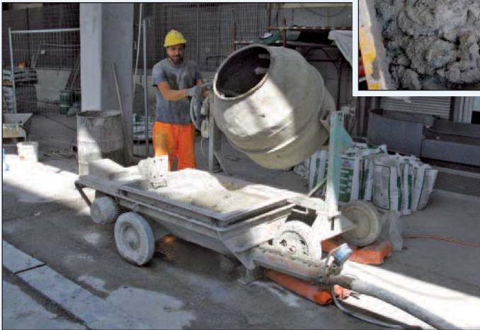
Figura 4 - Lo scarico dalla betoniera nella tramoggia della macchina
