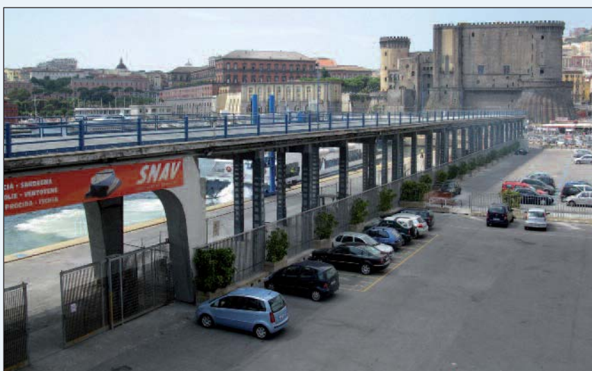
Figura 1 - Il porto di Napoli con le pensiline di sbarco lato Nord e Sud del molo Angioino
