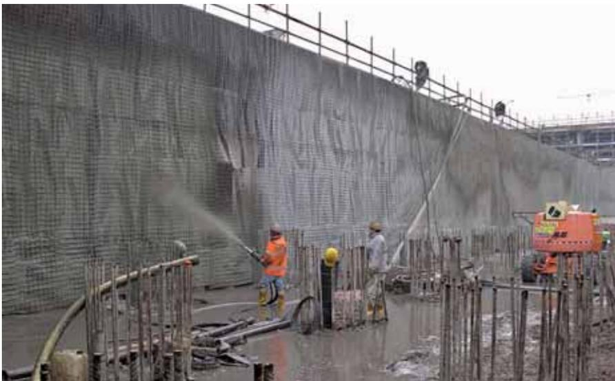
Lo spritz beton, realizzato grazie alla Bunker B100, ha coinvolto l'intera parete di fondazione dalle agguardevoli dimensioni di 75x42 m e 6,7 m di altezza. La B100, a totale funzionamento oleodinamico, permette una regolazione progressiva della portata e della pressione ed è in grado di pompare calcestruzzo fino a un'altezza di 25 m e una distanza di 60 m.
