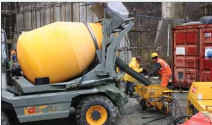
La pompa a cavità elicoidale B100 per calcestruzzo mentre viene alimentata da una betoniera nel cantiere del viadotto Ferriere
