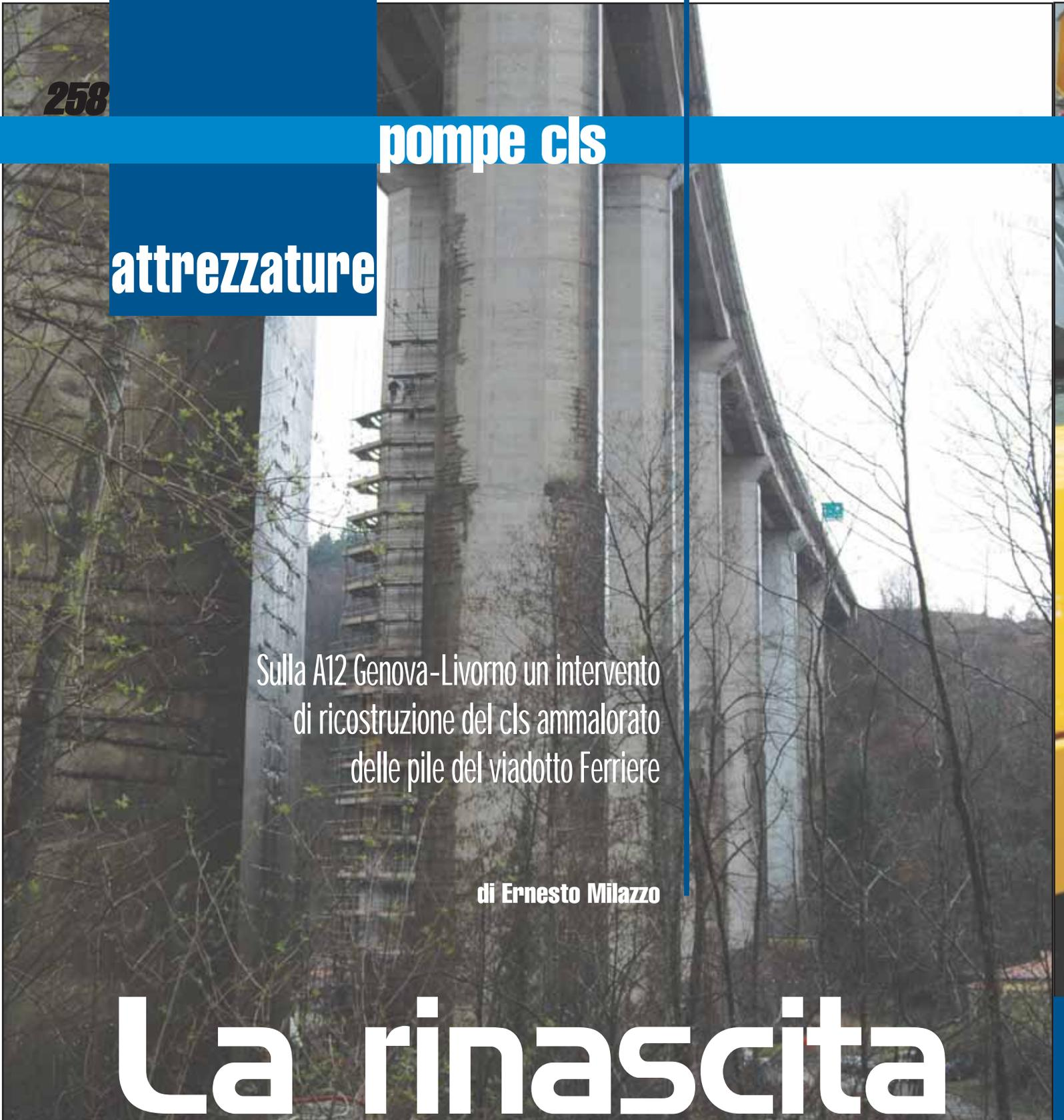
Sulla A12 Genova-Livorno un intervento di ricostruzione del cls ammalorato delle pile del viadotto Ferriere
