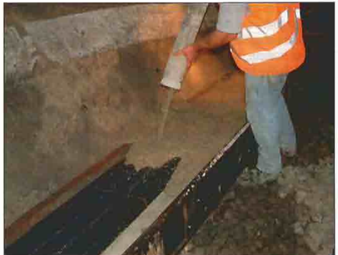
Un dettaglio del getto delle canaline: in evidenza le guaine protettive per la rete impiantistica
