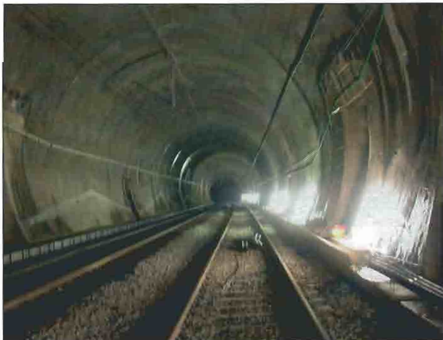
La galleria ferroviaria di Vasto Sud messa in sicurezza
