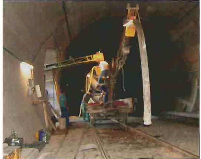
Il carrobotoniera pronto per iniziare il getto
