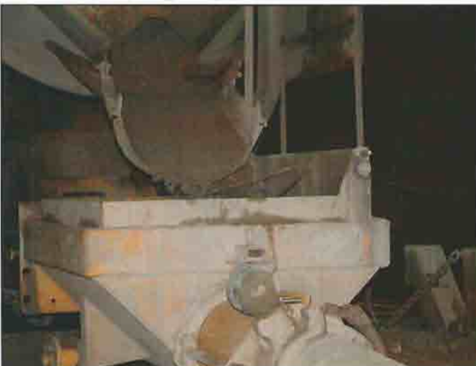
Le operazioni di carico della tramoggia della B100
