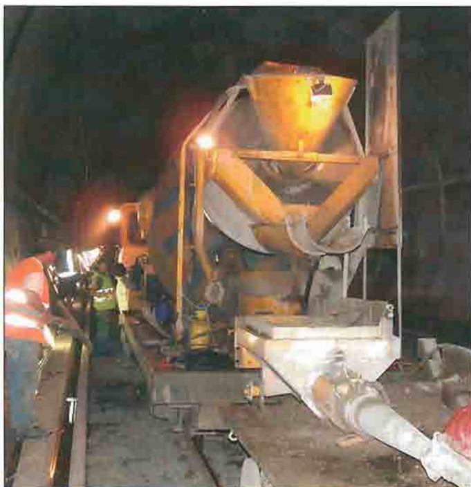
Il carro betoniera durante le operazioni di getto
