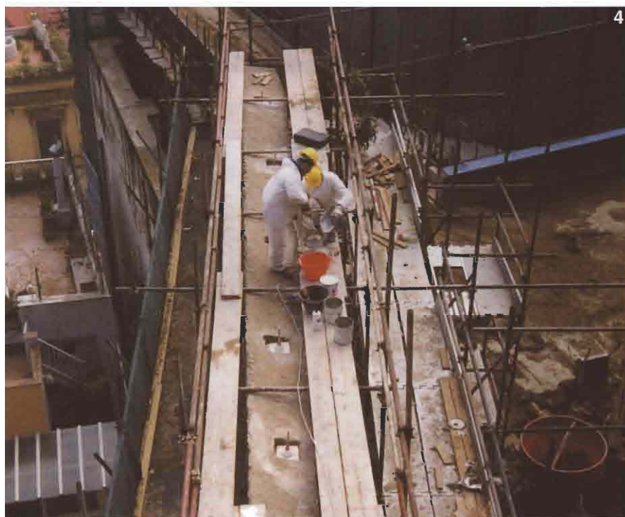
1 - 2 Le strutture dell'Aula Magna 3 Le mura sovrastanti dell'Aula Magna ad intervento eseguito 4 Fasi con messa in opera dei tiranti in fibra di carbonio
