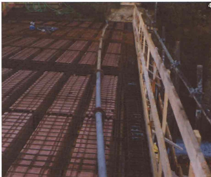
1 - 2 Lavori di sbancamento sull'area destinata ad ospitare l'Aula Magna 3 - 4 Il getto delle solette in cls mediante pompe a cavità elicoidale
