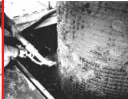
Spruzzatura di malta fibrorinforzata
