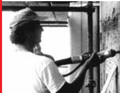
Applicazione di intonaco tradizionale o premiscelato
