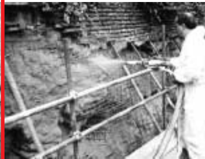
Spruzzatura di betoncino
