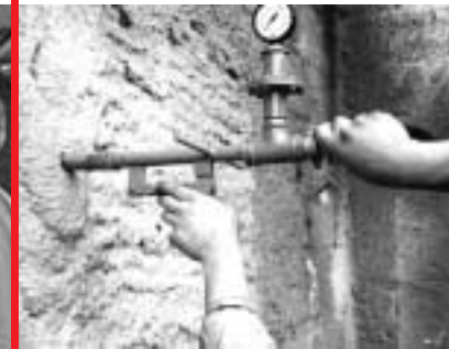
Iniezioni di boiacca a pressione controllata
