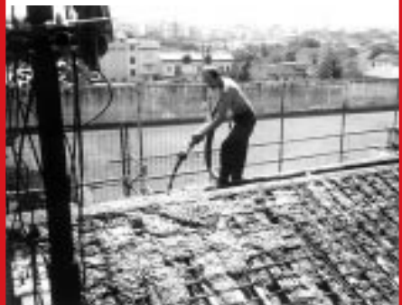
Pompaggio di malta e prodotti isolanti
