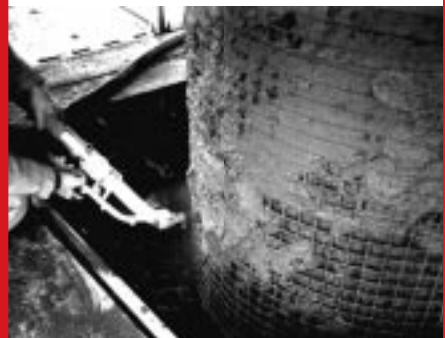
Spruzzatura di malta fibrorinforzata
