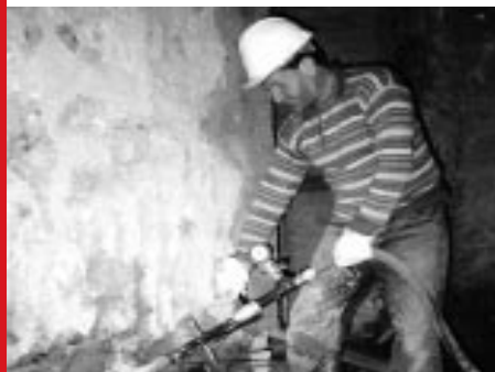
Iniezioni di boiacche cementizie a pressione controllata
