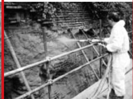
Spruzzatura di betoncino
