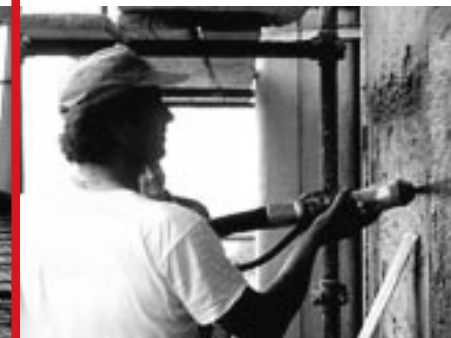
Applicazione di intonaco tradizionale o premiscelato
