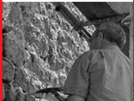
Riempimento giunti e connesure
