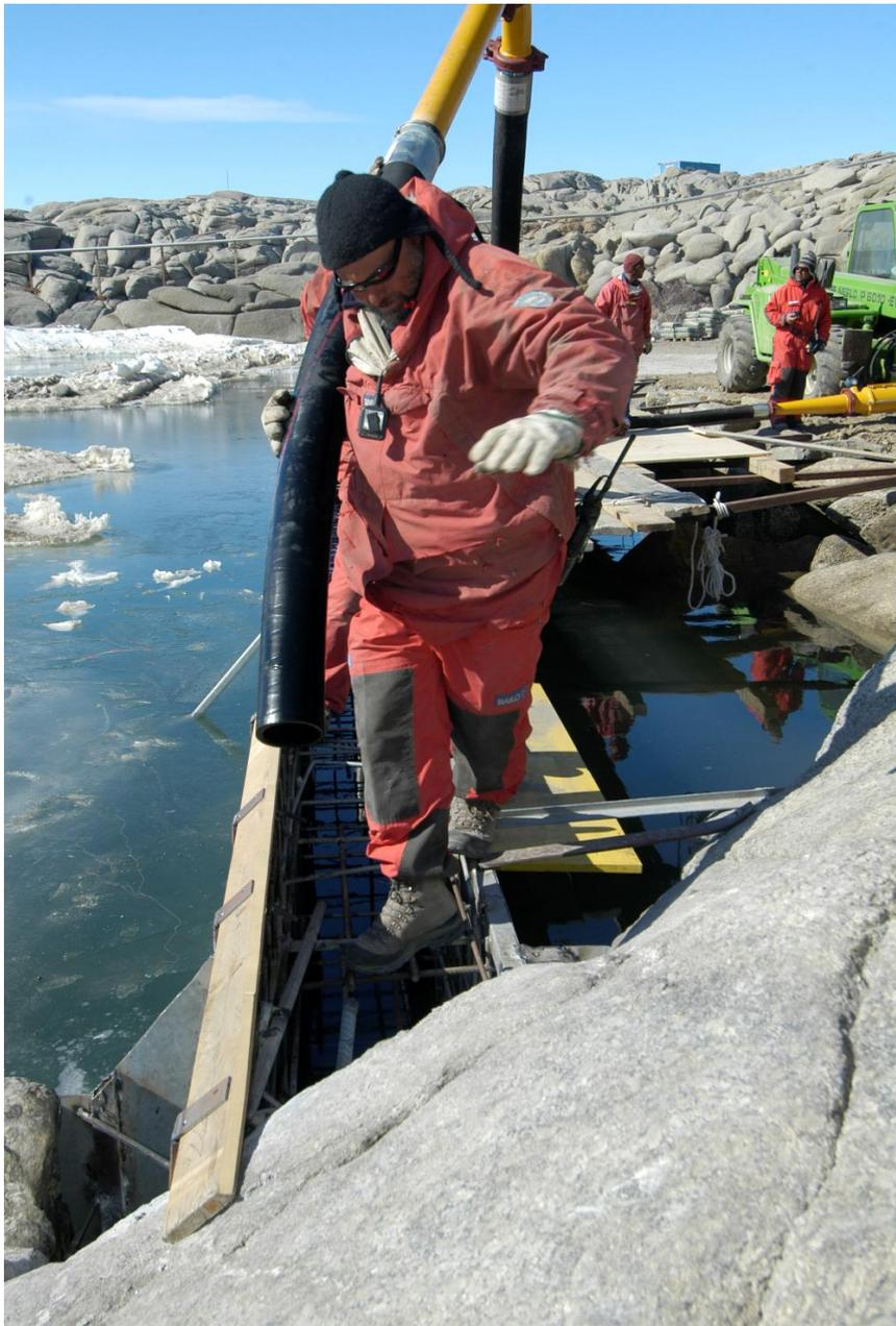
**Figura 5 POSIZIONAMENTO DEL TUBO DI POMPAGGIO**
