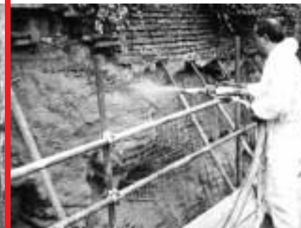
Béton projeté avec S8 SMART
