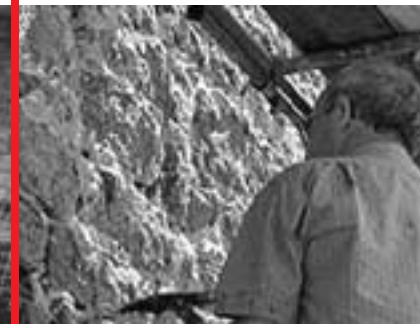
Réalisation d'un rejointoiement
