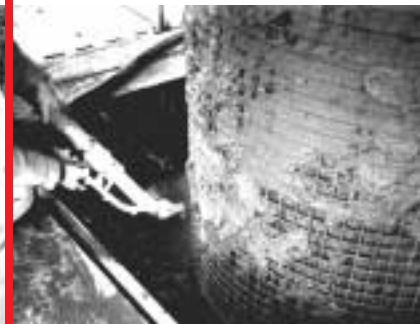
Projection de mortier fibré
