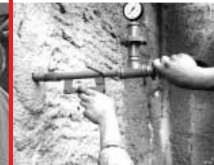
Injection de coulis de ciment
