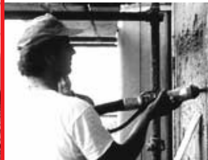
Application d'enduit pré-mélangé
