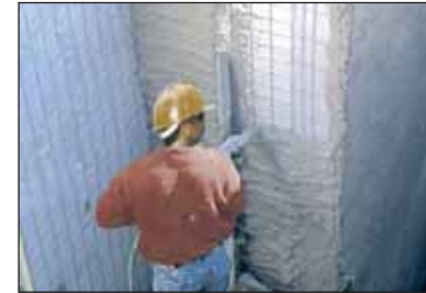
Projection de mortier sur panneaux de polystyrène avec treillis soudé
