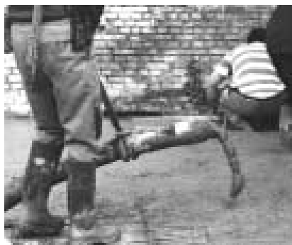
Pompage de béton
