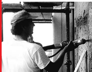
Aplicação de reboco tradicional ou pré-misturado
