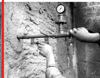
Injecções de calda de cimento com pressão controlada
