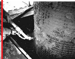
Projeção de argamassas reforçado com fibras
