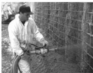
Concreto projetado (micro-concreto)
