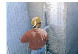
Spruzzatura di betoncino su pannelli di polistirene con rete metallica
