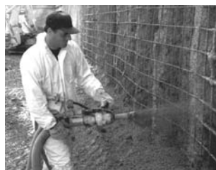
Calcestruzzo proiettato (spritz-beton)
