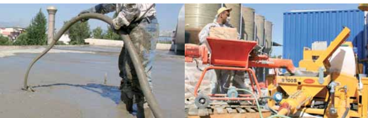
Pompage de béton cellulaire
