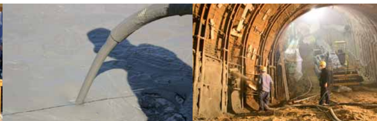
Pompage de béton cellulaire
