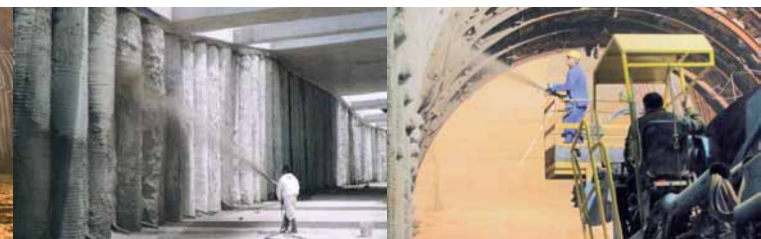
Béton projeté dans un tunnel
