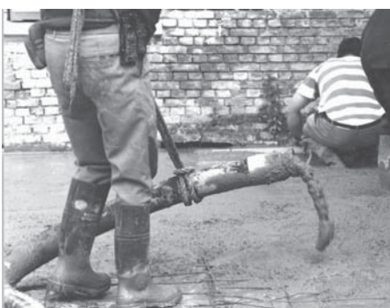
Pompage de béton
