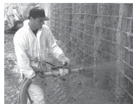
Béton projeté (spritz-beton)
