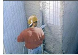
Proyección de mortero en paneles de poliestireno con red metálica
